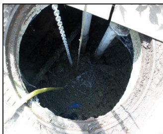
Esempi di vasche di sollevamento con catena per estrazione pompa sommersa
