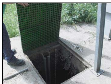
Esempi di vasche di sollevamento con catena per estrazione pompa sommersa
