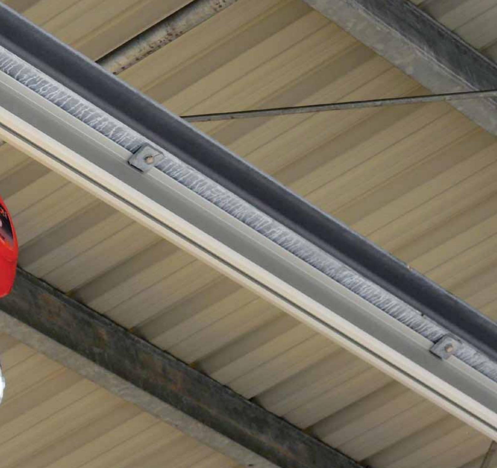
Binario in alluminio conforme alla norma EN 1808 "Requisiti di sicurezza per le piattaforme sospese a livelli variabili" e EN 795 classe D particolarmente adatto ai lavori in sospensione, in particolare per lavori di manutenzione di facciate continue
