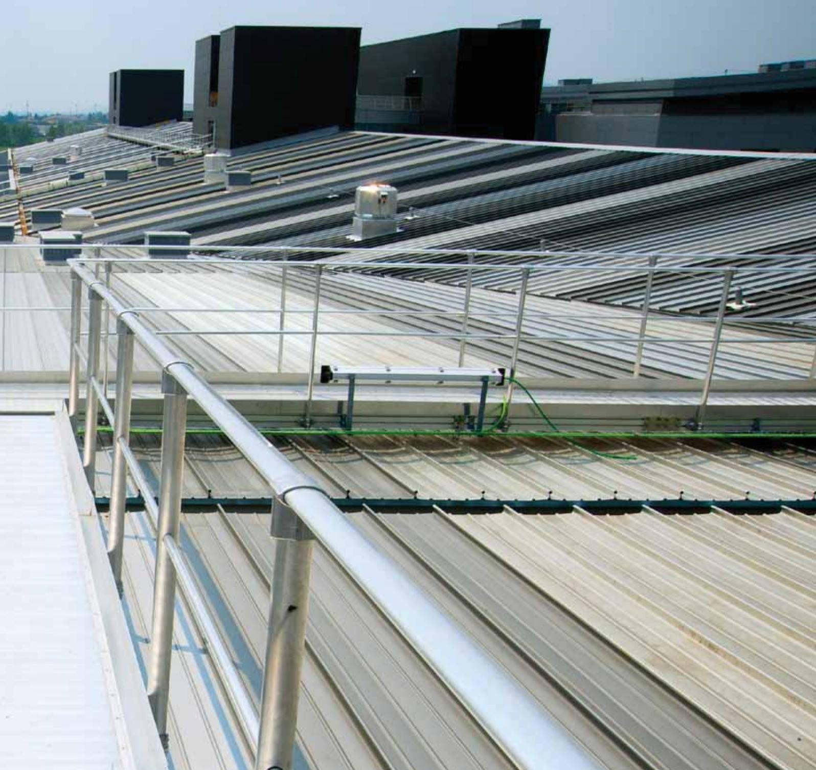
Passerelle in alluminio conformi alla norma EN ISO 14122-2 e EN ISO 14122-3
