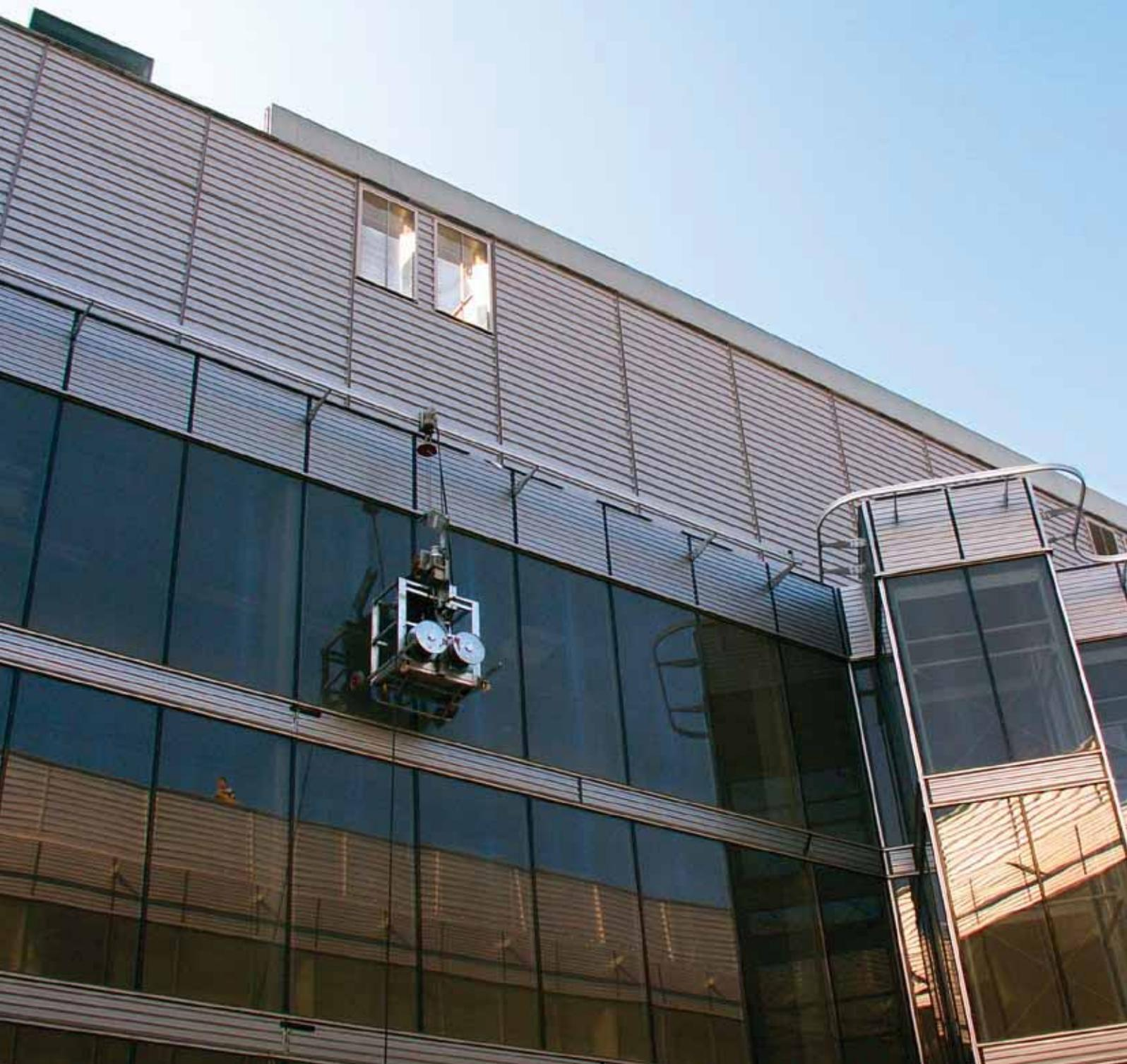
Sistemi per la manutenzione di costruzioni a facciate continue
