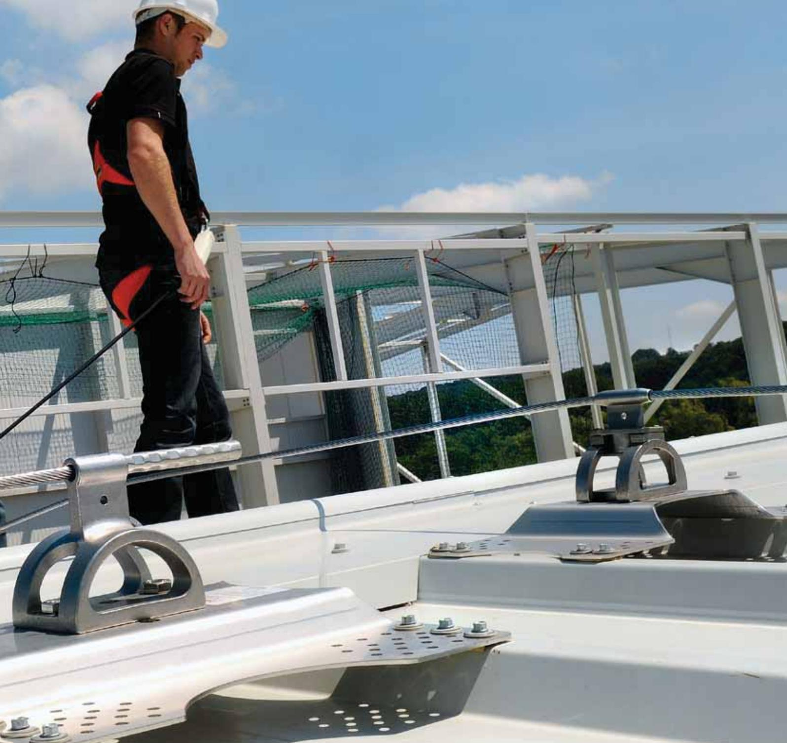
Linea vita in classe C adatta alla messa in sicurezza di coperture in lamiera e strutture fragili
