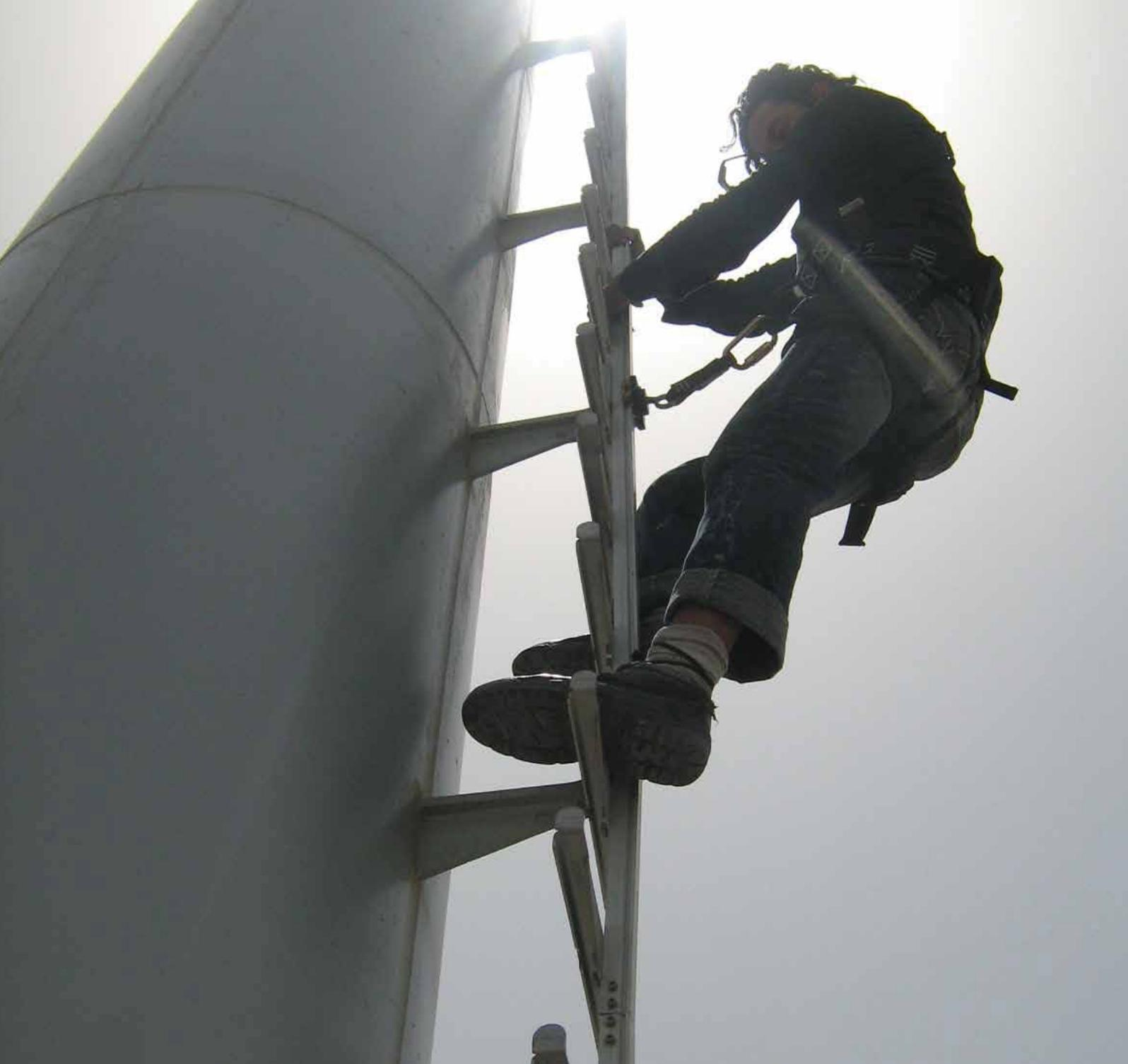
Linea vita conforme alla norma EN 353-1 adatta alla messa in sicurezza di tratti verticali o con una pendenza superiore ai 15°
