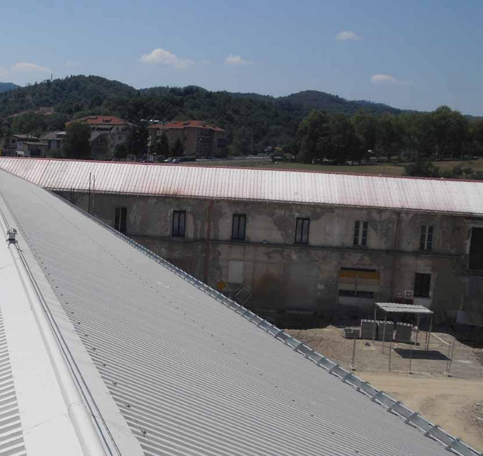
Linea vita in classe C in alluminio indeformabile, conforme alla norma EN 795 Classe C
