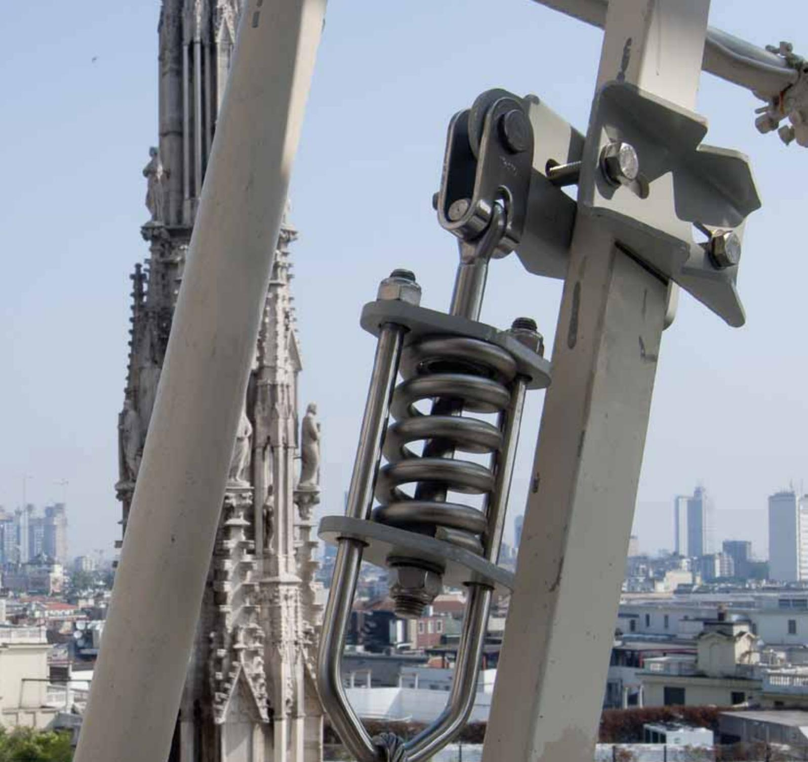
Linea vita conforme alle norme EN 353-1 e 353-2 adatta alla messa in sicurezza di tratti verticali
