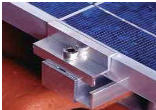
Sistema di fissaggio del pannello
