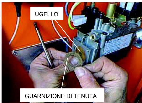
Figura 37 – Sostituzione ugello
