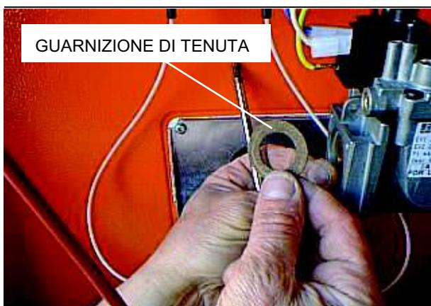
Figura 36 – Guarnizione di tenuta
