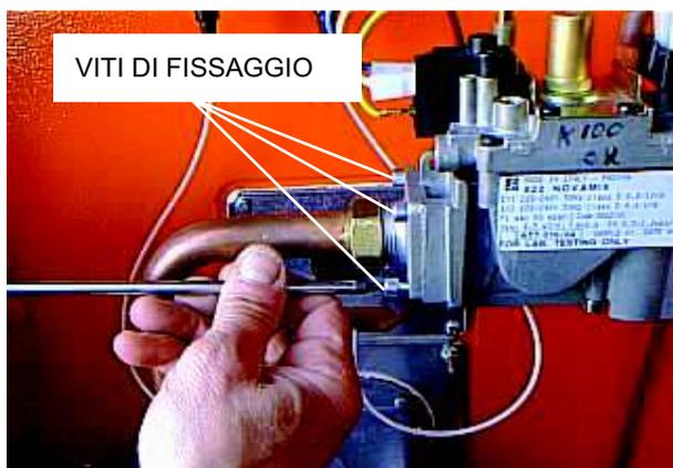
Figura 34 – Viti di fissaggio flangia gas
