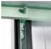
Dispositivo paracadute inserito nelle guide. Agisce in caso di rottura delle funi bloccando la caduta dell'anta mobile.
