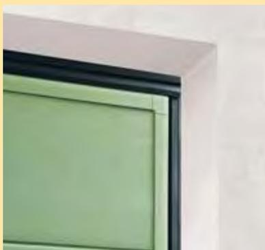
Porta Plana con posa oltre luce, con questo tipo di posa le coperture non sono necessarie.
