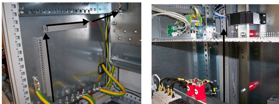
Figura 3-22 Posa del cavo di comunicazione
