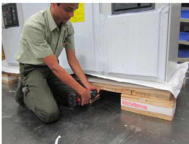
Figura 3-2 Rimozione dei bulloni senza sollevare l'inverter.
