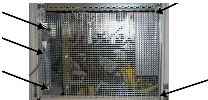
Figura 3-8 Rimozione della barriera dell'alimentatore CA principale
