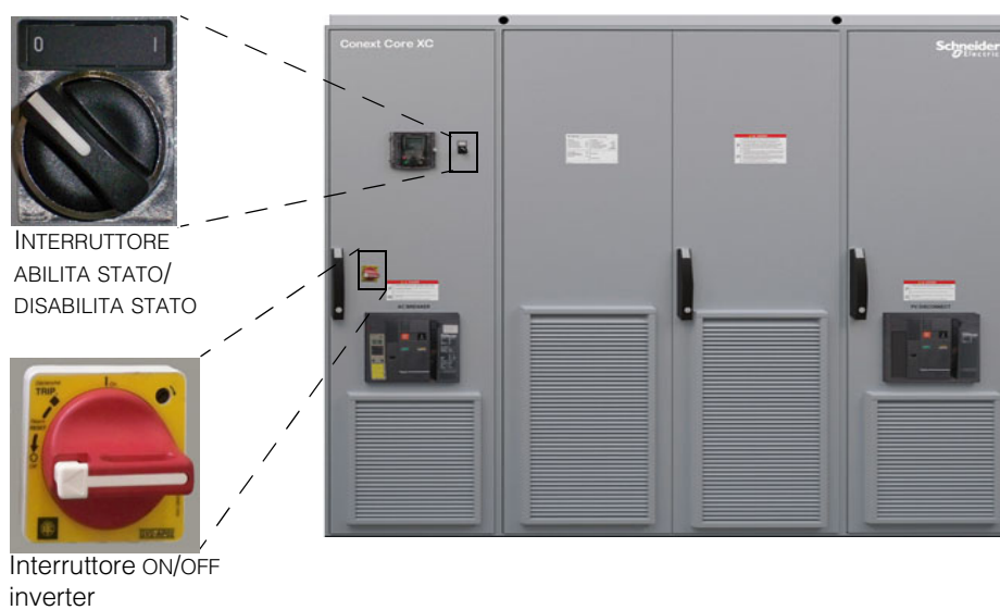
Figura 1-2 Interruttore ABILITA STATO/DISABILITA STATO e interruttore ON/OFF inverter
