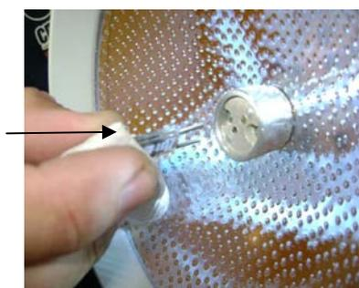
Não tenha contato direto com a lâmpada, *utilize um pano limpo e seco*. Segure na lâmpada e retire-a puxando para baixo até desencaixá-la do “soquete”, troque a lâmpada e repita toda a operação inversamente.
