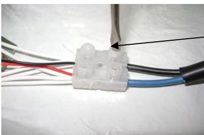
Faça a conexão do cabo SINDAL, apertando bem os parafusos. Recoloque a tampa.
