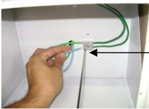
Faça a conexão dos cabos verde/azul ao SINDAL, **apertando bem os parafusos** (fig).
