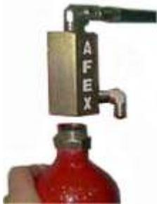
1. Verifique as condições físicas do atuador pneumático e seu suporte. O atuador deverá estar fixo em seu suporte e os dois deverão estar em boas condições. Verifique se o suporte estará montado adequadamente.
