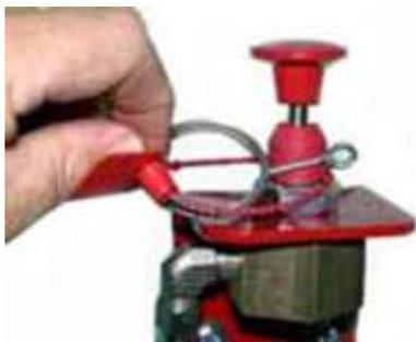
12. Coloque um lacre novo no pino de segurança e assegure-se que esteja firme. É necessário instalar o lacre firmemente para que se rompa quando o pino de segurança do mecanismo disparador for removido.
