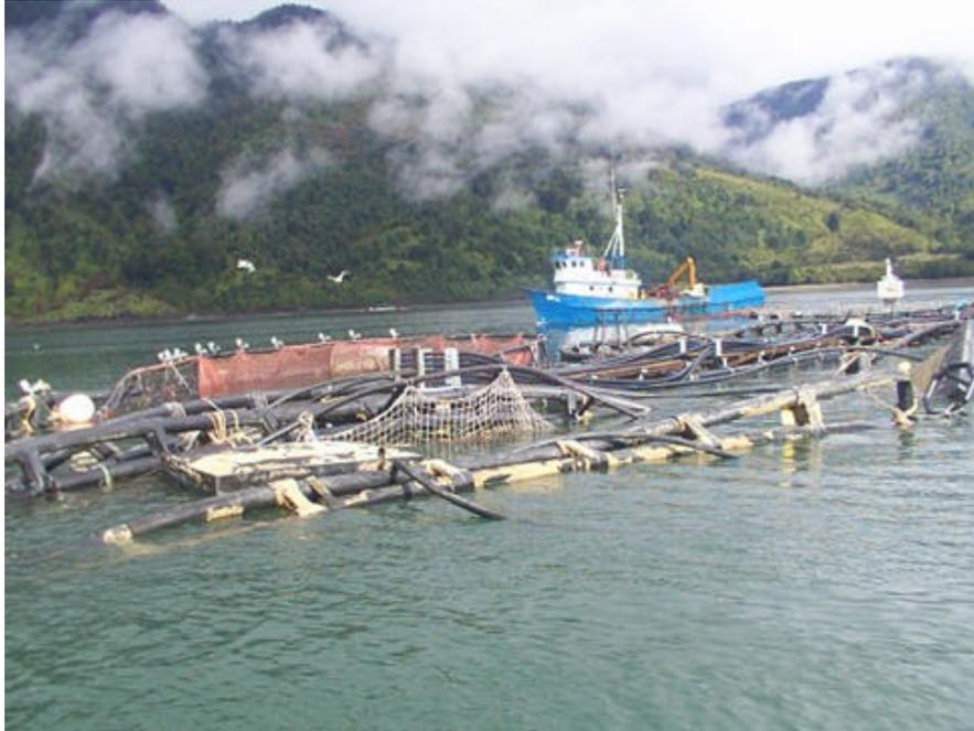
**Figura 11. Estrutura dos tanques-rede completamente destruída por interferência climática. Provavelmente instalação mal feita. Escape de 100% dos peixes.**
