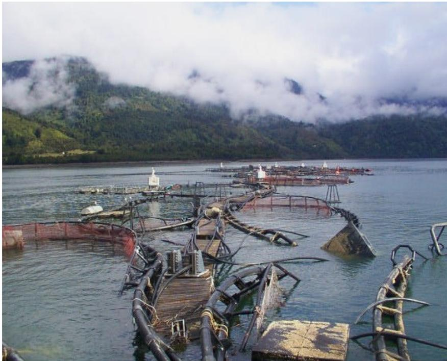
**Figura 10. Estrutura dos tanques-rede completamente destruída por interferência climática. Provavelmente instalação mal feita. Escape de 100% dos peixes.**
