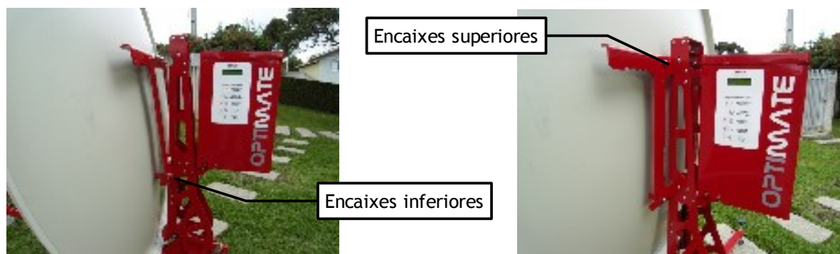
Encaixe da Parábola na estrutura central
