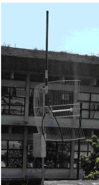
**Figura 45: Nó mesh montado com duas antenas**
