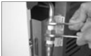
3. Coloque a porca do adaptador na entrada de gás. Em seguida, encaixe o adaptador e rosqueie a porca de fixação no adaptador. Utilize duas chaves de boca para auxiliar o aperto.
