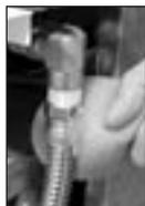
4. Verifique se há vazamento de gás, colocando um pouco de espuma de sabão em todas as conexões que foram manuseadas.
