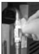
6. Rosqueie a mangueira metálica no registro de gás com o auxílio de duas chaves de boca. Utilize fita Teflon® ou pasta vedante para auxiliar na vedação.
