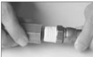
1. Rosqueie o adaptador junto à mangueira metálica flexível. Para auxiliar na vedação, utilize pasta vedante ou fita Teflon®.
