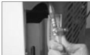
1. Coloque a braçadeira de metal em uma das pontas da mangueira. Em seguida, encaixe a mangueira no ponto de entrada de gás.
