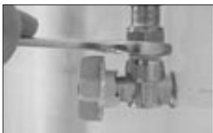
3. Se você estiver utilizando gás encanado, rosqueie a mangueira metálica no registro de gás da parede com o auxílio de duas chaves de boca.
