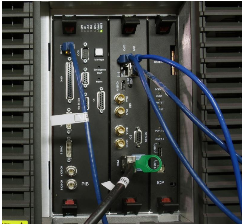
Figura 17: Projetor Christie Series-2 com o IMB instalado
