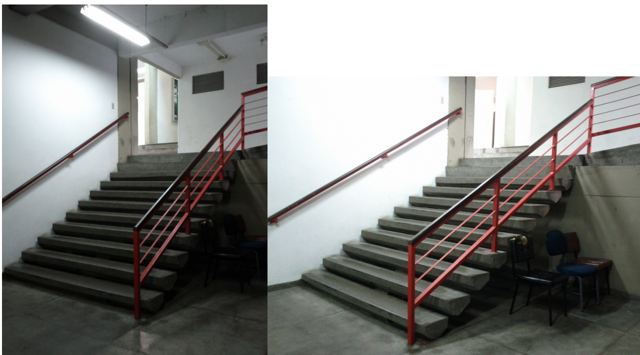
Figura 31: Escada da UTFPR bloco A.
