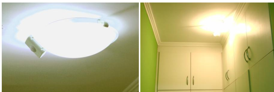
**Figura 83 - Iluminação com sensor de movimento**
