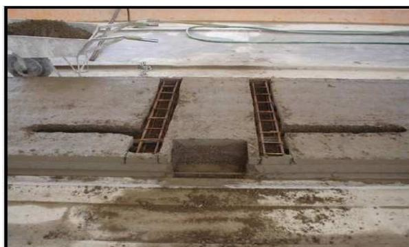
FIGURA 24 – Reforço no recorte de pilar feito na pista (PETRUCELLI, 2009)
