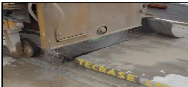
FIGURA 27 – Execução de um corte transversal na laje (PETRUCELLI, 2009)
