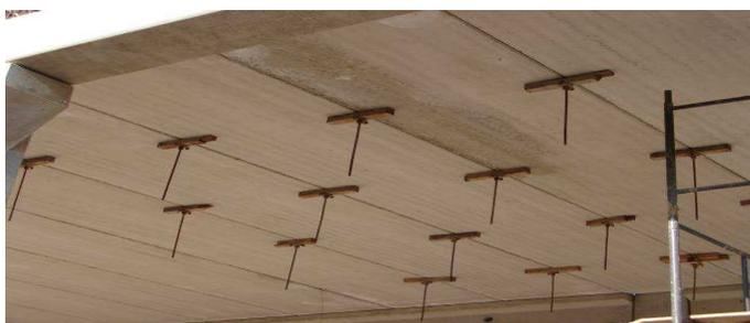
FIGURA 37 - Posicionamento dos torniquetes para equalização das lajes (PETRUCCELLI, 2009)
