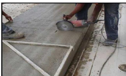
FIGURA 25 – Execução de um recorte de pilar no painel com concreto fresco (PETRUCELLI, 2009)
