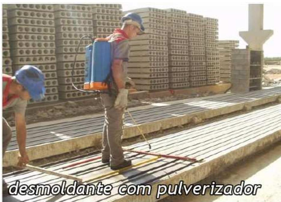
FIGURA 18 – Aplicação de desmoldante com pulverizador (PETRUCELLI,2009)
