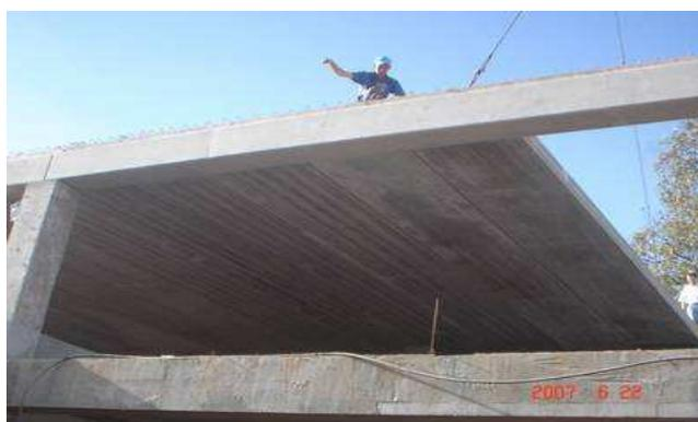
FIGURA 36 – Posicionamento de uma laje alveolar (PETRUCELLI, 2009)
