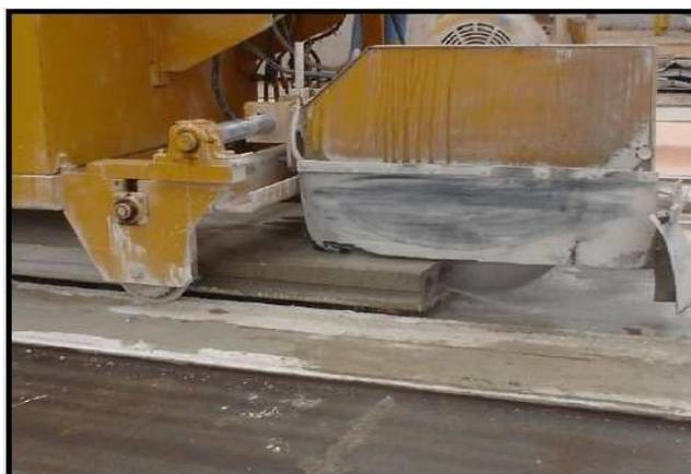
FIGURA 28 – Execução de um corte longitudinal na laje (PETRUCELLI, 2009)
