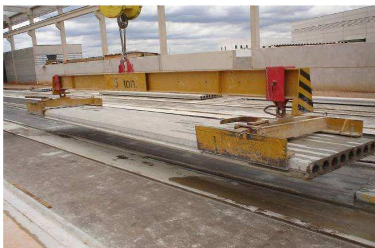
FIGURA 29 - Içamento das lajes através do sistema de garras e balancins (PETRUCELLI, 2009)
