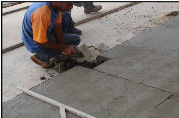
FIGURA 23 – Execução de um recorte de pilar em concreto fresco (PETRUCELLI, 2009)
