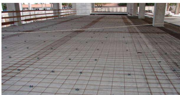
FIGURA 40 -Distribuição das telas soldadas para posterior concretagem da capa (PETRUCCELLI, 2009)
