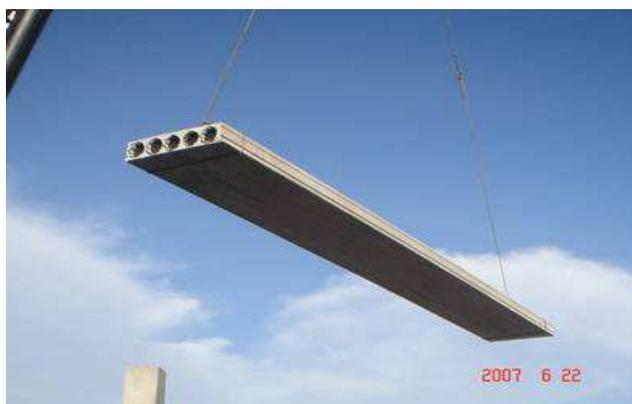
FIGURA 35 – Içamento de uma laje alveolar (PETRUCELLI, 2009)
