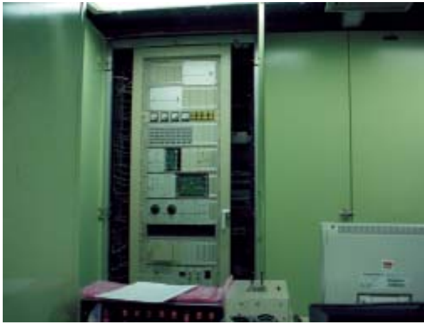
FIGURA 2. Visualização do painel da excitação e do regulador de tensão da UPME - B
