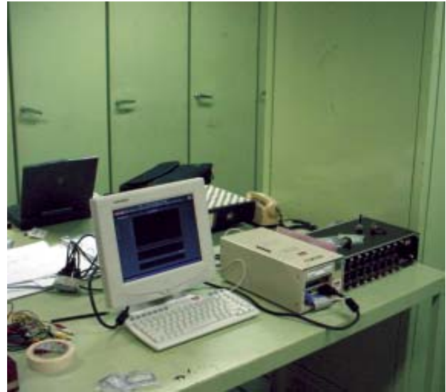
FIGURA 3. Instrumentação para realização dos ensaios dos reguladores da UPME - B
