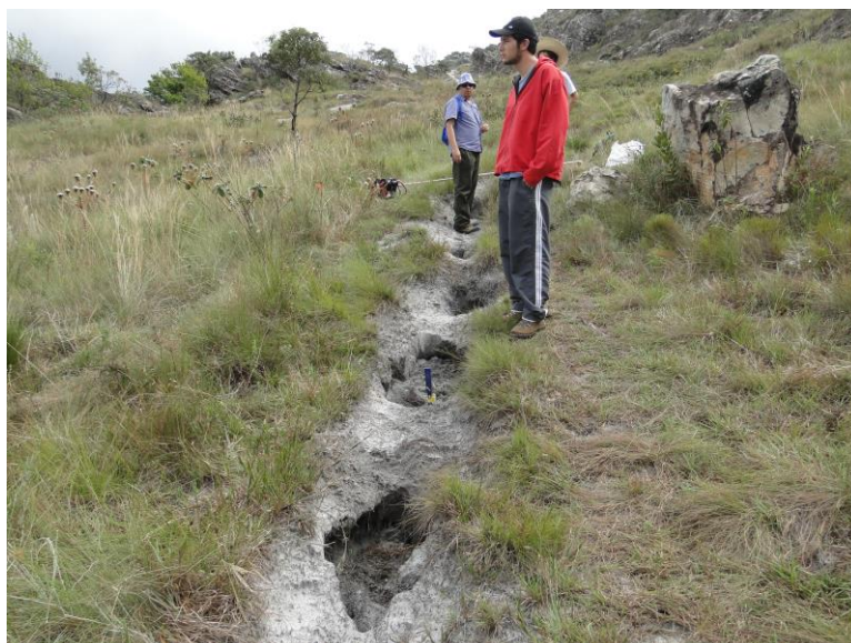
Figura 7: Degradação da trilha por solapamento basal (erosão subsuperficial) e knick points (erosão concentrada superficial). Foto: A. C. Campos
