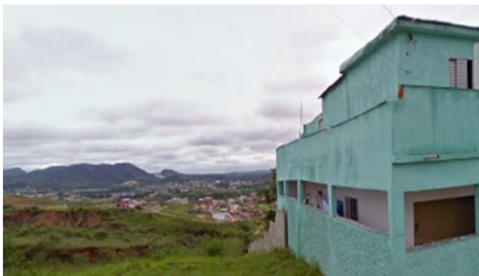
Figura 1: Loteamento nas proximidades de uma voçoroca em pleno estado de instabilidade.
