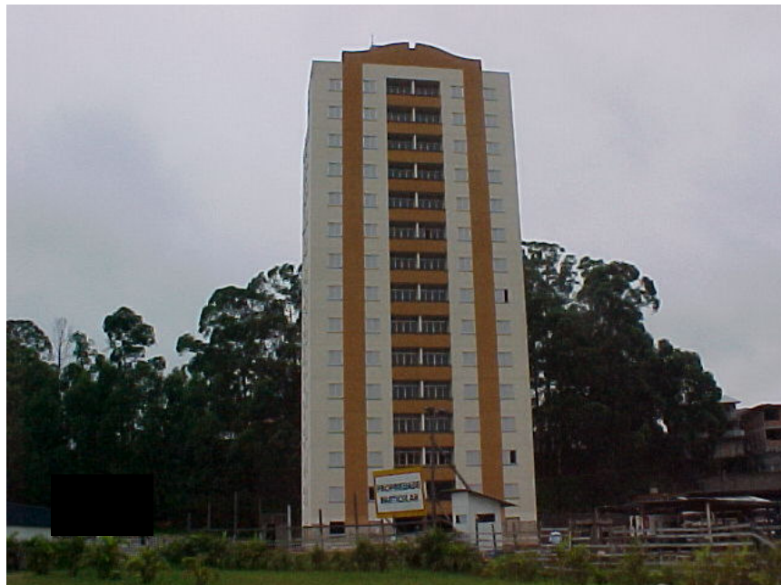
Figura 3.7 Vista de uma das torres do Empreendimento do Estudo de Caso E
