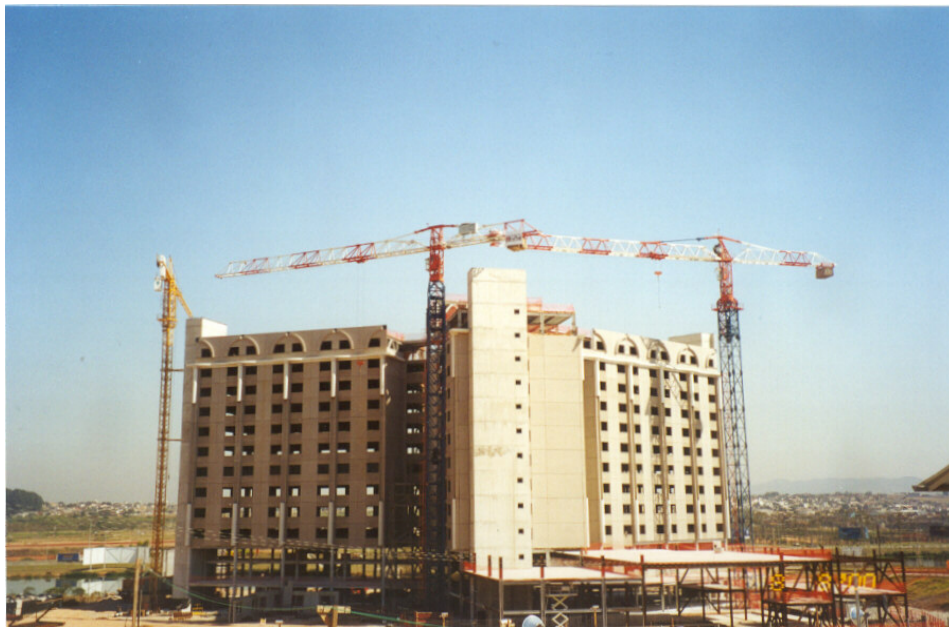
Figura 3.13 Vista frontal do empreendimento 1 – Estudo de Caso G
