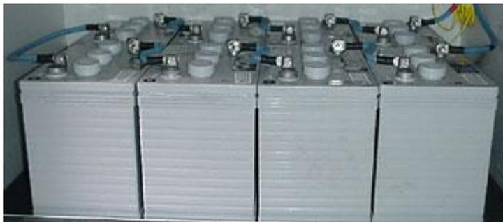
Figura 2.8 - Banco de baterias numa aplicação solar [1]
