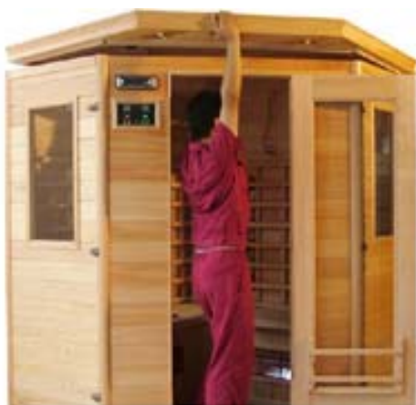
FIG-16 Instalación del panel del techo interior
