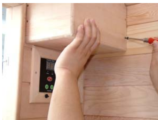
FIG-24.1 Fije la caja con tornillos
