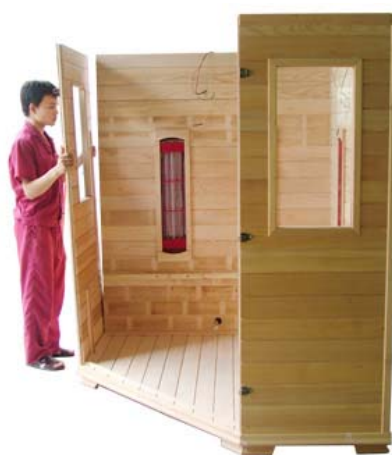
FIG-8 Instalación del panel lateral izquierdo
