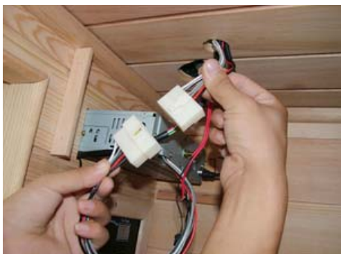
FIG-20 Conecte los cables del CD
