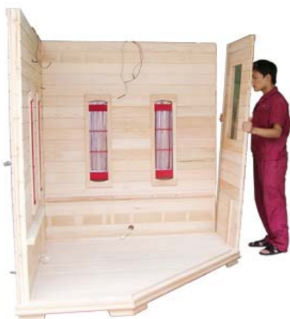
FIG-7 Coloque o painel do lado direito
