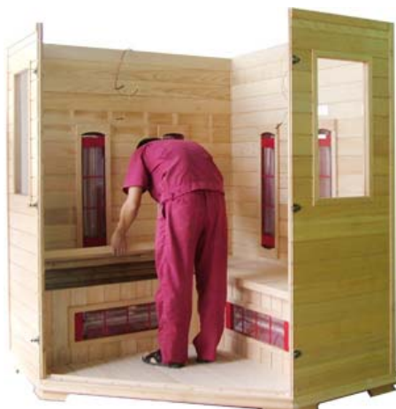
FIG-12.1 Instalación del banco
