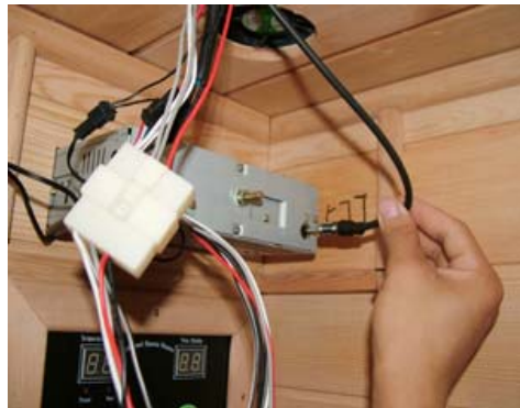
FIG-23 Conecte el cable de la antena
