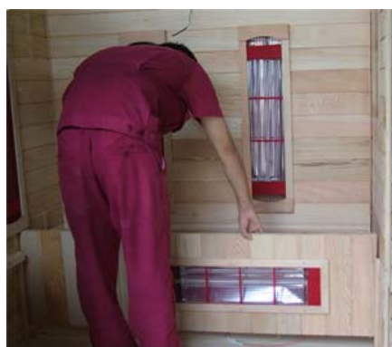
FIG-9 Instalación panel inferior largo calefactado
