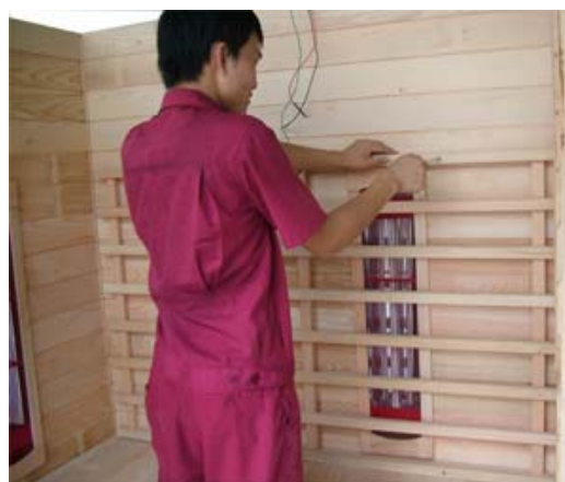
FIG-13 Afixe o painel das costas com parafusos
