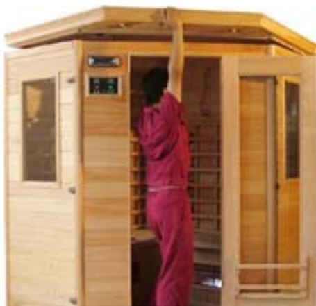
FIG-16 Ajuste o painel superior interno
