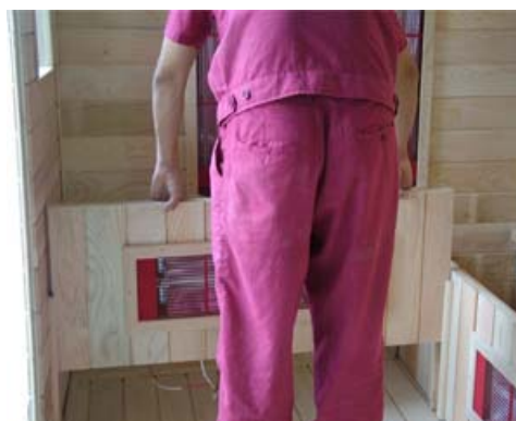
FIG-10 Instalación panel inferior corto calefactado
