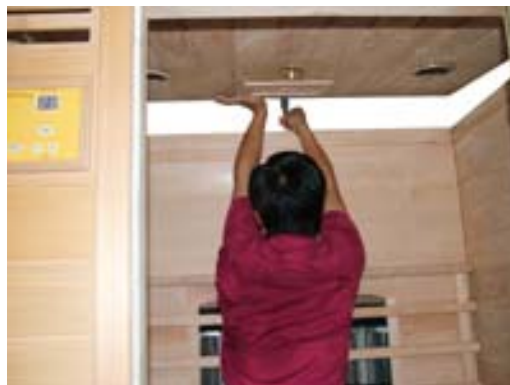
FIG-17 Ponga los cables del calefactor en el agujero correspondiente
