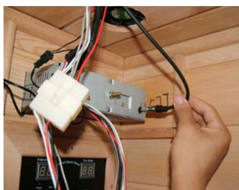
FIG-23 Ligue os fios da antena
