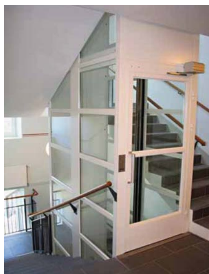
Figura 2. O Motala 6000 é geralmente instalado numa escada já existente, algo possível pela capacidade compacta do design .
