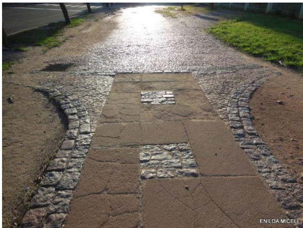
Início do calçamento com inserção de caminho posterior ao original.
