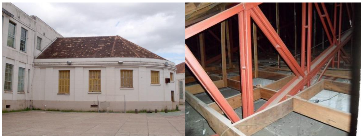
Telhado do Auditório
