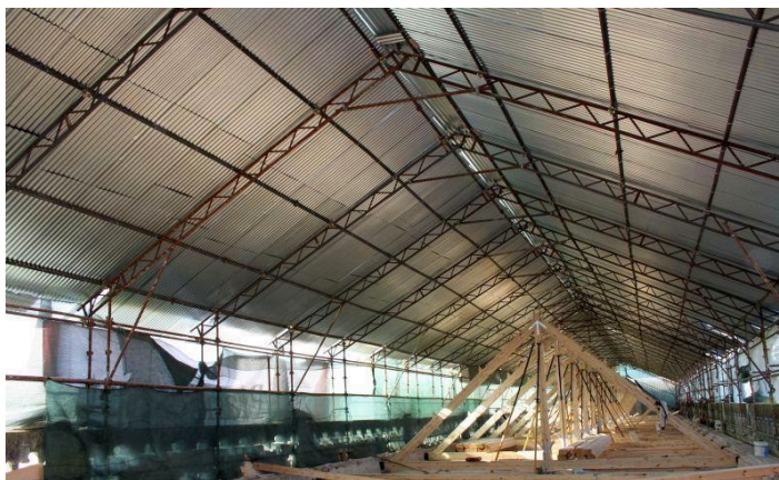
Foto da cobertura provisória do convento dos Jerônimos, em Portugal durante o restauro.
