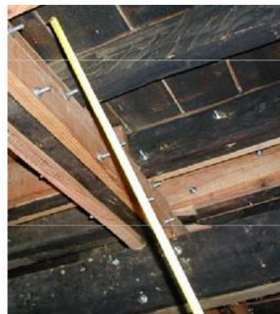
Detalhe de braçadeira metálica para reforço no vigamento
