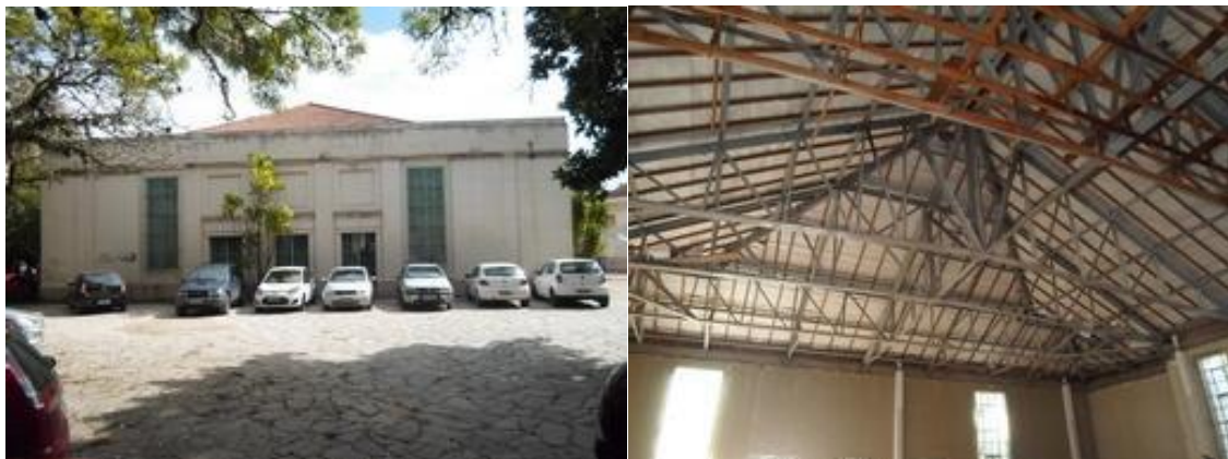
Telhado do Ginásio de esportes
