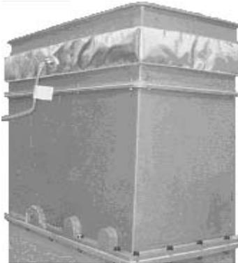
1. Retire os compartimentos de protecção e o isolamento térmico.
