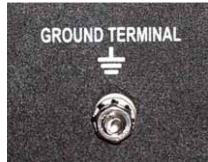
Figure 7 - Mise à la terre de la génératrice
