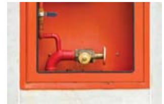
FIGURA 12 Hidrante exterior
