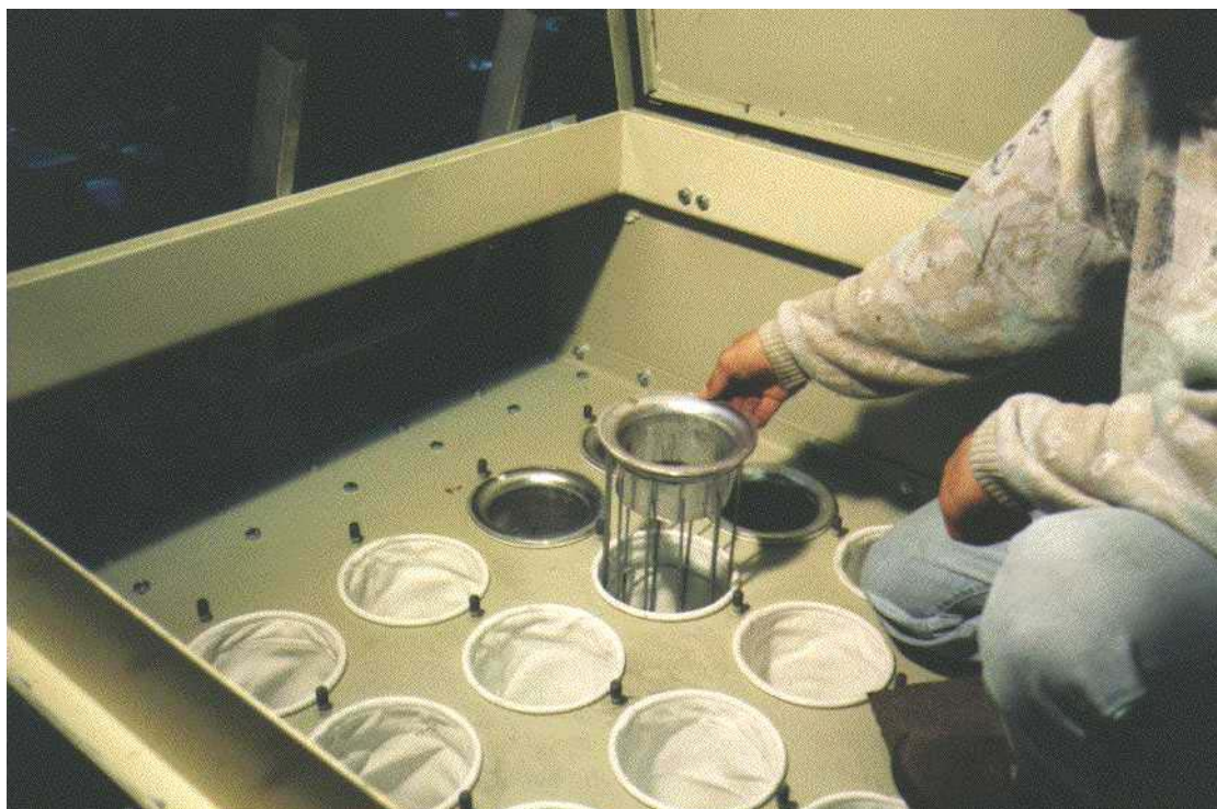
Figura 26: Montagem da gaiola suporte
