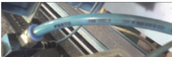
Figura 70 – Mangueiras, sistemas pressurizados.
