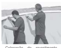
Colocação do revestimento vinílico feito pelo SQM - Sibrape Quality Made.
