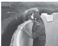
Aplicação dos dispositivos de filtragem e de iluminação. Fixação do perfil de PVC.
