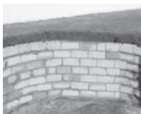
Levantamento das paredes.
