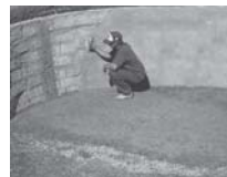
Reboco liso nas paredes, fundo em concreto leve. Aplicação de base amortecedora.
