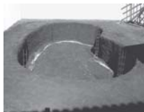
Escavação e construção das brocas e colunas.
