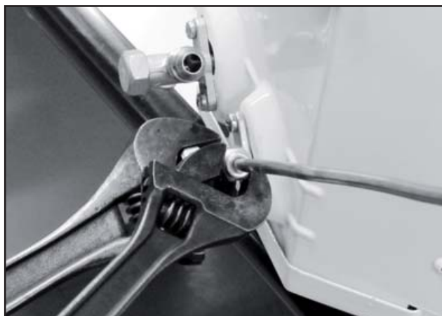
FIGURA 24 - FIXAÇÃO DA PORCA
