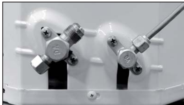
FIGURA 25 - CONEXÃO DA LINHA DE EXPANSÃO DA UNIDADE CONDENSADORA
