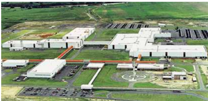
Figura Ab.7 – Fábrica de Caminhões e Ônibus
