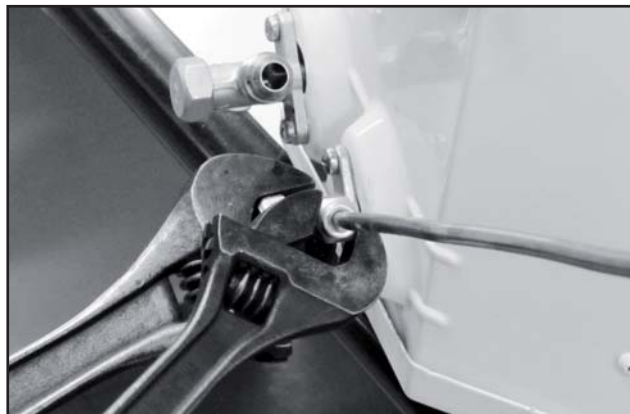
FIGURA 31 - FIXAÇÃO DA PORCA
