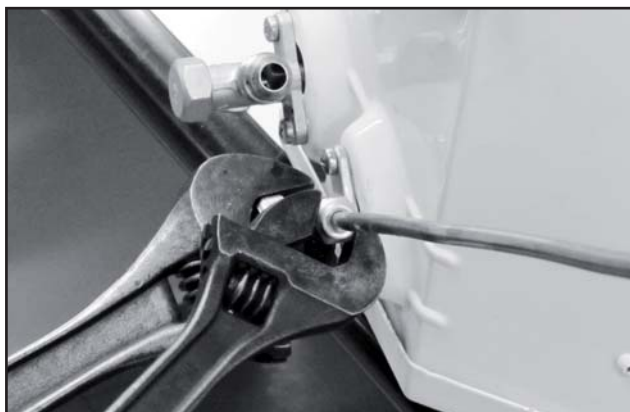
FIG. 26 - FIXAÇÃO DA PORCA
