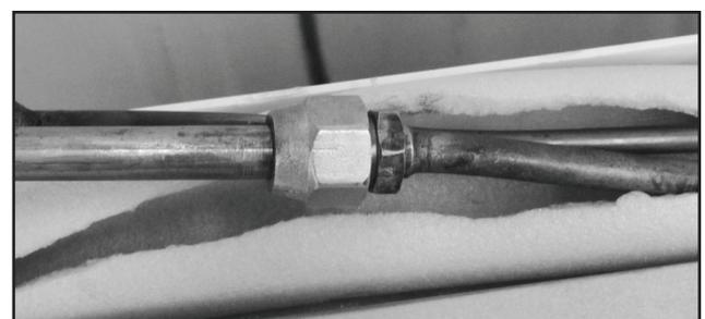
FIG. 34 - CONEXÃO DA LINHA DE SUCÇÃO DA UNIDADE EVAPORADORA
