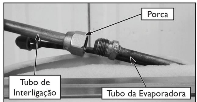
FIG. 33 - CONEXÃO DA LINHA DE SUCÇÃO
