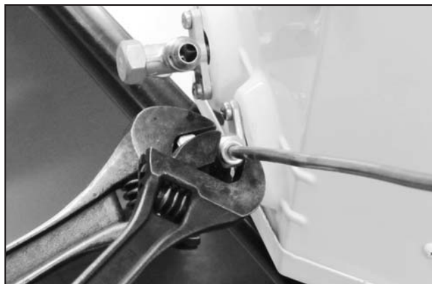
FIG. 31 - FIXAÇÃO DA PORCA
