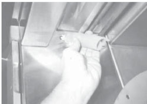
1. Empurre e rode a lâmpada no sentido inverso ao dos ponteiros do relógio para remover a lâmpada danificada.
