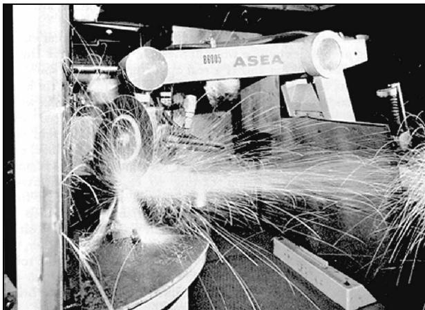
Sem os canais, a peça ainda pode apresentar rebarbas que prejudicam seu funcionamento e causam má impressão visual. Nesta fase, a utilização de robôs industriais tem-se mostrado bastante adequada. Com a utilização de ferramentas abrasivas rotativas, estas máquinas, obedecendo à seqüência de instruções – os programas – podem se adaptar à uma grande variedade de geometrias de peças e rebarbar seus contornos com precisão e rapidez.
