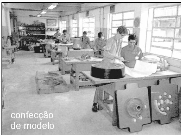
2. **Confeção do molde** – O molde é o dispositivo no qual o metal fundido é colocado para que se obtenha a peça desejada. Ele é feito de material refratário composto de areia e aglomerante. Esse material é moldado sobre o modelo que, após retirado, deixa uma cavidade com o formato da peça a ser fundida.
