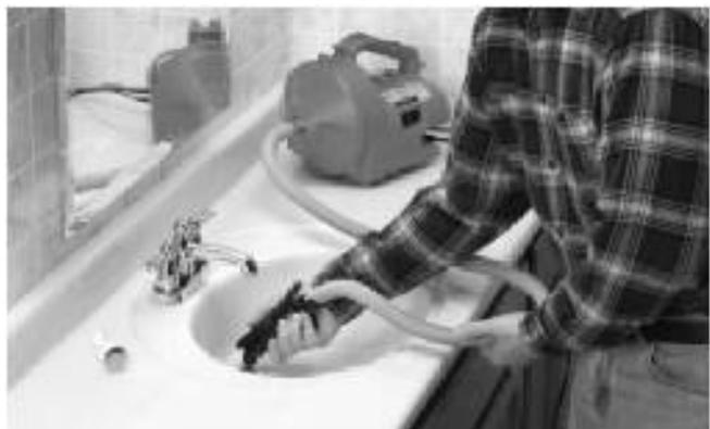
Figura 7 – Inserção do cabo na abertura da tubulação
