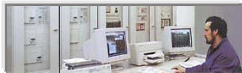
Figura 3.31 – Sala de Comando de uma subestação digital com o operador agindo através do sistema de supervisão
