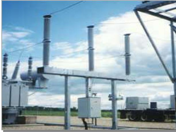
*Figura 3.9 – Aspecto visual de um disjuntor de alta tensão instalado em uma subestação*
