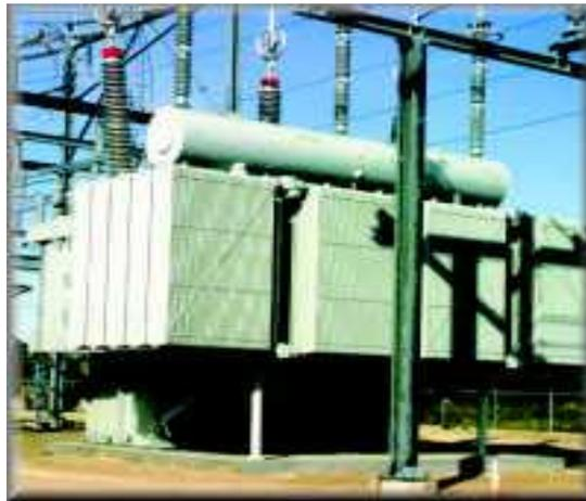
*Figura 3.6 – Aspecto físico de um transformador de potência trifásico tipo ONAN*
