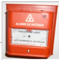
O alarme de incêndio deve ser acionado por qualquer pessoa, quando for detectado um incêndio. Destina-se a alertar as pessoas para que elas abandonem imediatamente o prédio. Ao ser acionado, um avisador sonoro tipo sirene ecoará e acenderá uma luz no quadro de incêndio na guarita, identificando o ponto onde o alarme de emergência foi pressionado.
