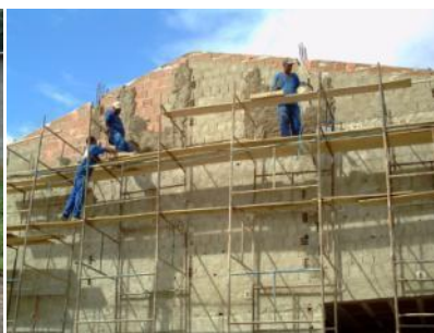
Figura 4 - Não utilização de cinto de segurança. Figura 5 – Área destinada às armações de aço. Figura 6 - Andaimes sem guarda-corpo.
