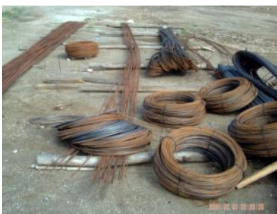
Figura 7 - Não utilização de EPI. Figura 8 – Armazenamento em solo natural. Figura 9 - Resíduos sólidos de construção. e sem coberta dos vergalhões.
