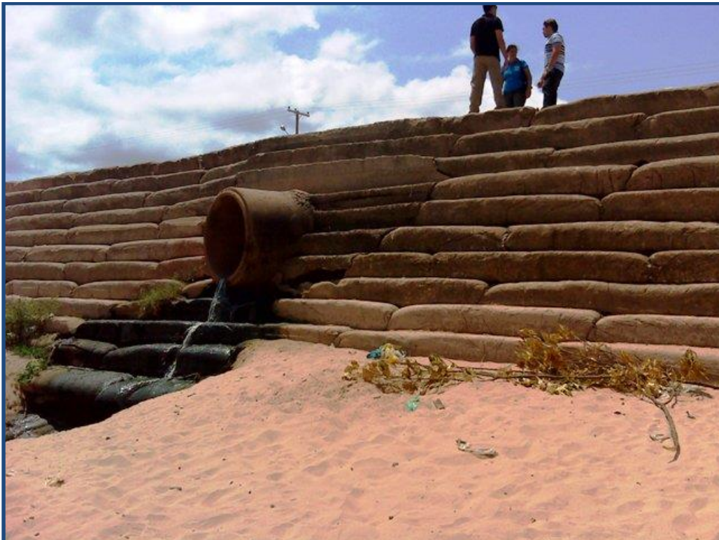
Figura 3- Detalhe do muro de contenção construído em bolsacreto para proteger o corpo do aterro da sazonalidade do rio.
