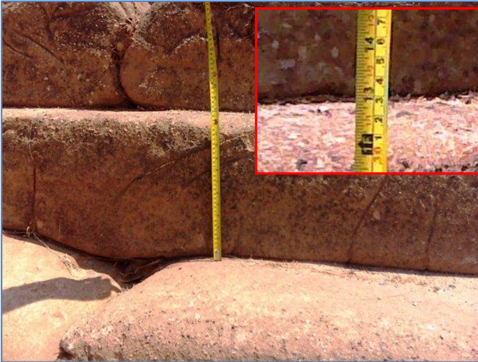
Figura 7 - detalhe da altura dos bolsacretos
