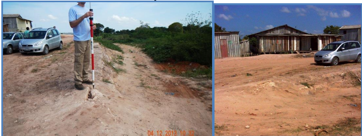
Figura 10 - Fotos detalhando as imediações do final do aterro Uruará, entre as estacas 40 e 42
