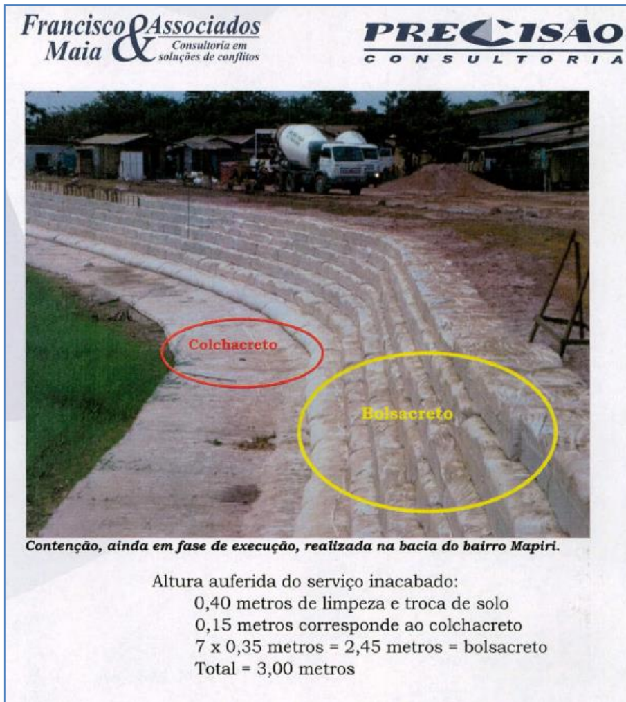
Figura 2 - método para se calcular as alturas de contenção
