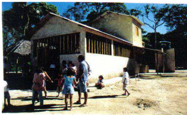
Figura 40 EMPI Três Palmeiras (vista por fora) Fonte: Arquivo da SEMED.
