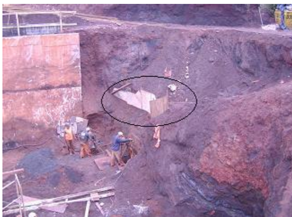
Figura 70– Barreira executada pelos trabalhadores
