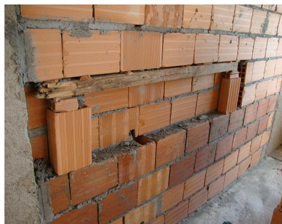
Figura 40 – Execução local do nicho na alvenaria
