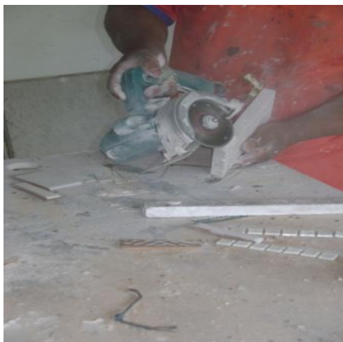
Figura 61 – Execução do chanfro no marco da porta
