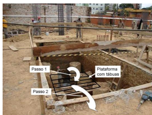
Figura 76 – Projeto para escavação de bloco sem plataforma com sarrilho
