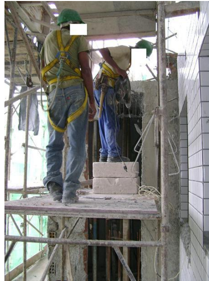
Figura 63 – Pedras sobre a plataforma do andaime
