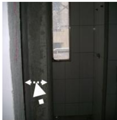
Figura 53 – Excesso a ser removido
