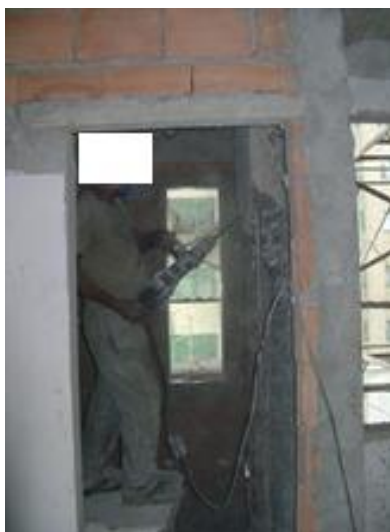
Figuras 64 e 65 – Retirada do excesso nos pilares do WC
