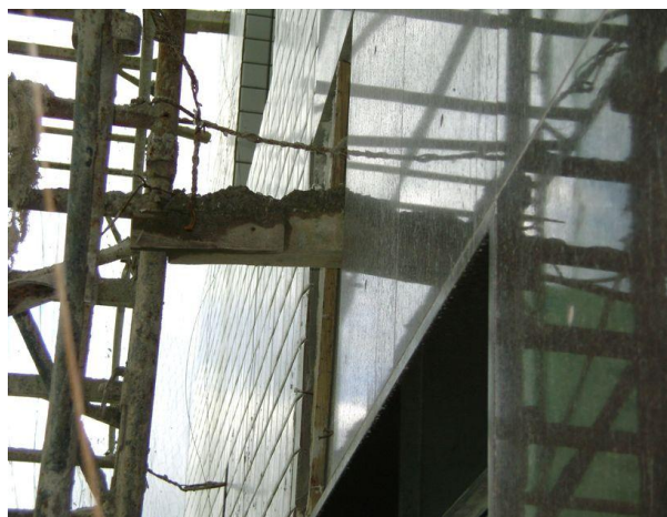
Figura 71 – Interferência para o assentamento do granito
