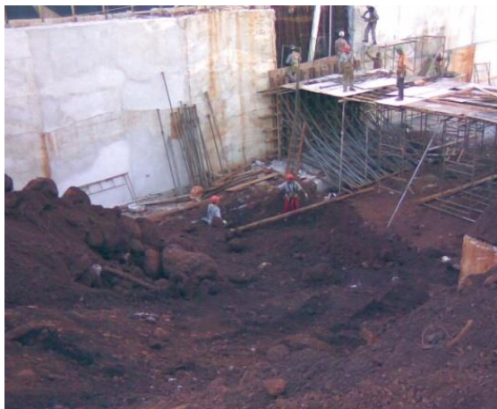
Figura 68 – Execução da fôrma do muro de contenção
