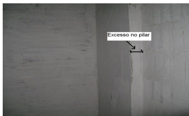
Figura 58 – Excesso no pilar do elevador
