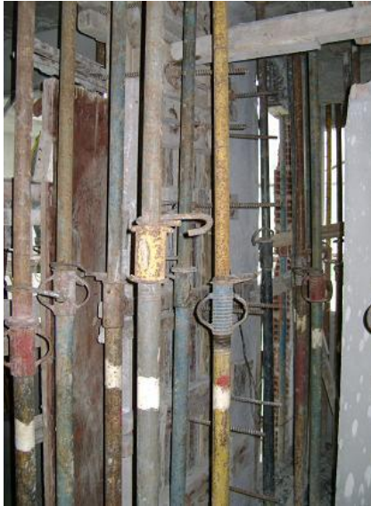
Figura 62 – Escoras dentro do WC
