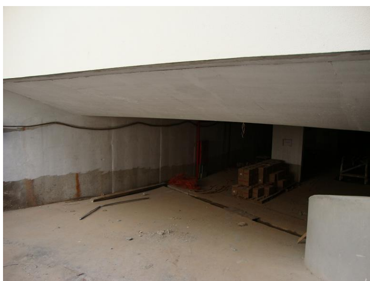
Figura 49 – Vista do ponto após execução
