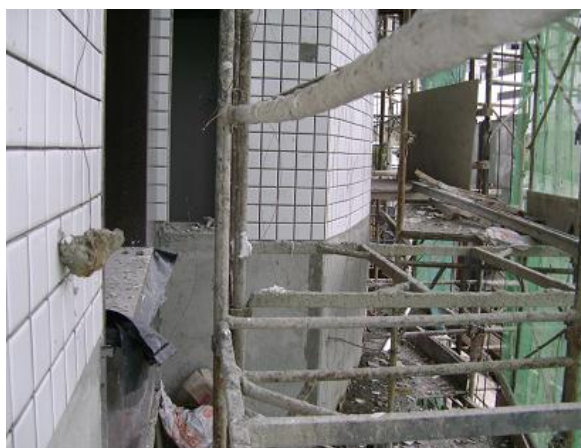
Figura 74— Sem interferência para o assentamento da cerâmica
