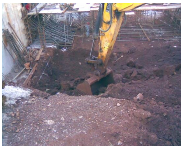
Figura 69 – Movimento de terra mecanizado
