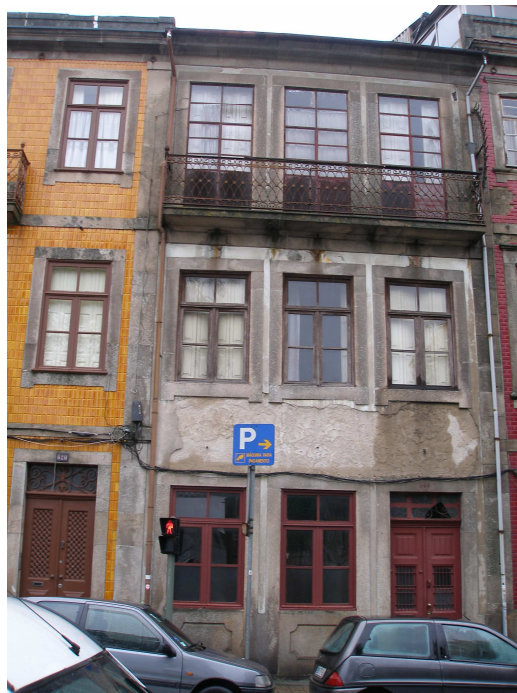
Fig. 14 – Edifício em estudo antes da reabilitação
