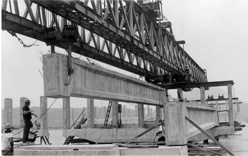
**Figura 5** – Ponte rolante com estrutura em treliça
