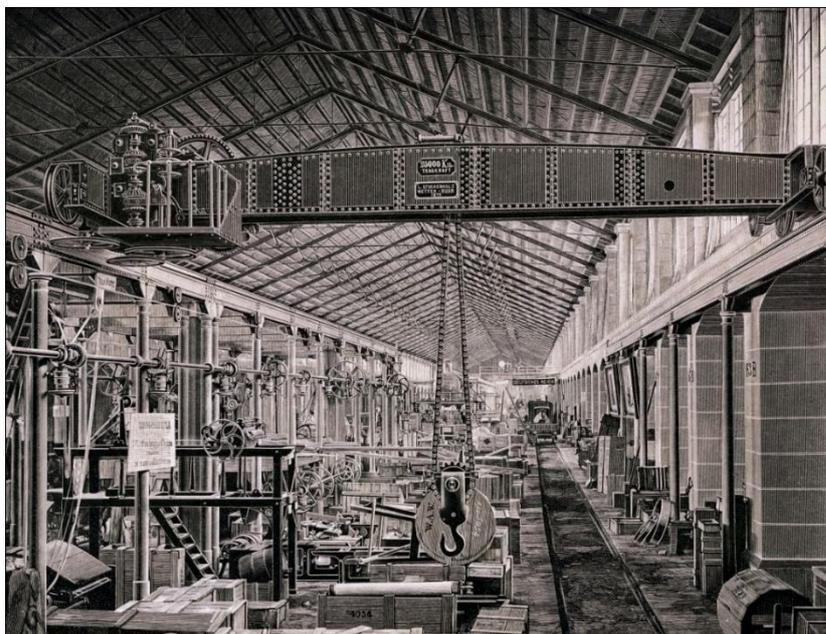
**Figura 2** – Ponte rolante do século XIX movimentada a vapor
