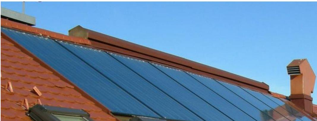
Figura 31: Sistema solar térmico integrado no telhado do edifício (Energia Lateral, 2014)
