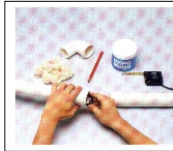
b) Colocar o anel de borracha na virola da bolsa, do tubo ou da conexão.
