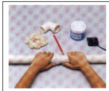
d) Encaixar a ponta chanfrada do tubo no fundo da bolsa, recuar 5mm no caso de canalizações expostas e 2mm para canalizações embutidas, tendo como referência a marca previamente feita na ponta do tubo. Essa folga se faz necessária para a dilatação da junta.
