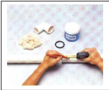
a) Marcar a profundidade da bolsa na ponta do tubo.
