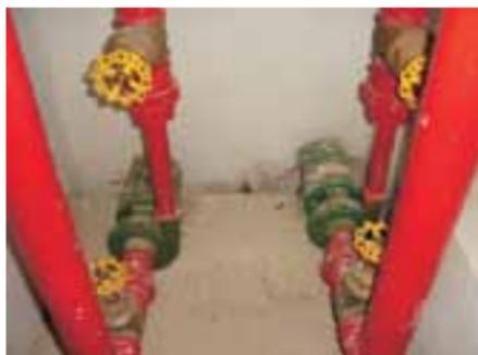
automáticos, pressurizam a rede ao ser rompido um sprinkler. As bombas de recalque podem ser acionadas por botoeiras do tipo liga-desliga, pressostatos, chaves de fluxo ou uma bomba auxiliar de pressurização (jockey).
