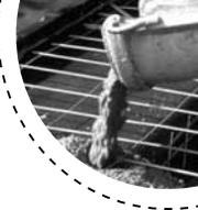
Aditivo para concreto, líquido pronto para o uso e livre de cloretos. Indicado para a produção de concreto uniforme e com maior qualidade. Possui em sua composição componentes que atuam como dispersantes do material cimentício, propiciando grande redução de água sem alteração do tempo de pega do concreto. Compatível com todos os tipos de cimento Portland. Atende os requisitos das normas brasileiras NBR 11768 (tipo P) e ASTM C494 (tipo A).
